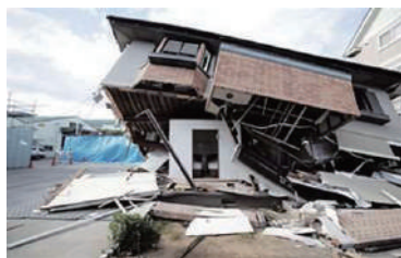
住宅耐震補強事業 耐震シェルター
